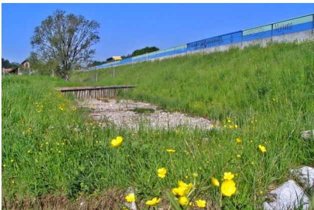
Slika 37: Rastlinska čistilna naprava za čiščenje padavinskega odtoka z avtoceste Ljubljana–Celje na odseku Hudinja.
