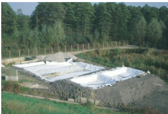
Slika 27: Izkop in polaganje filca za zaščito folije.
