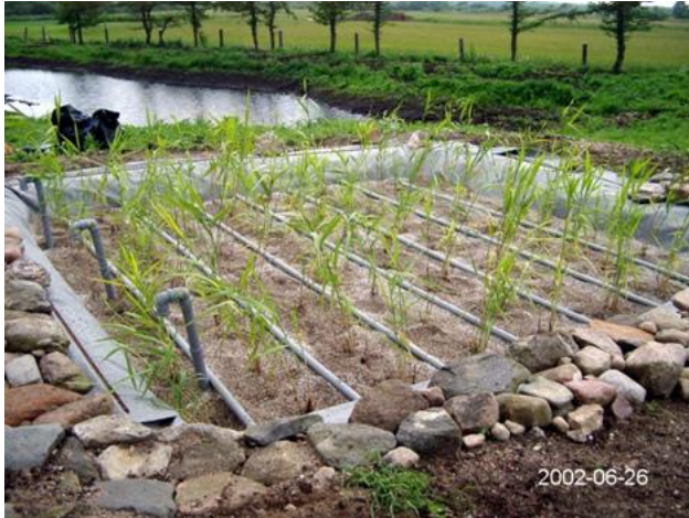
Slika 38: Rastlinska čistilna naprava z vertikalnim tokom vode za čiščenje komunalne odpadne vode Mørke, Denmark (Carlos Arias, 2002).
