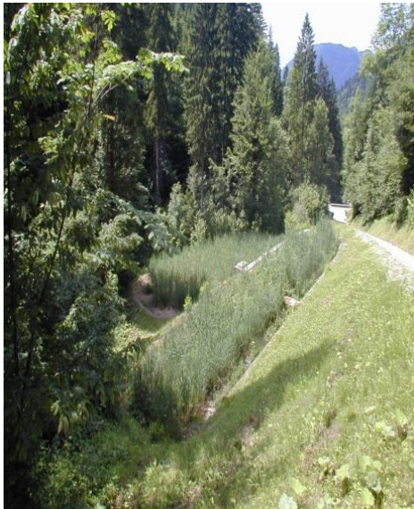
Slika 32: Horizontalna rastlinska čistilna naprava za čiščenje izcedne vode iz odlagališča komunalnih odpadkov Ljubevč pri Idriji.
