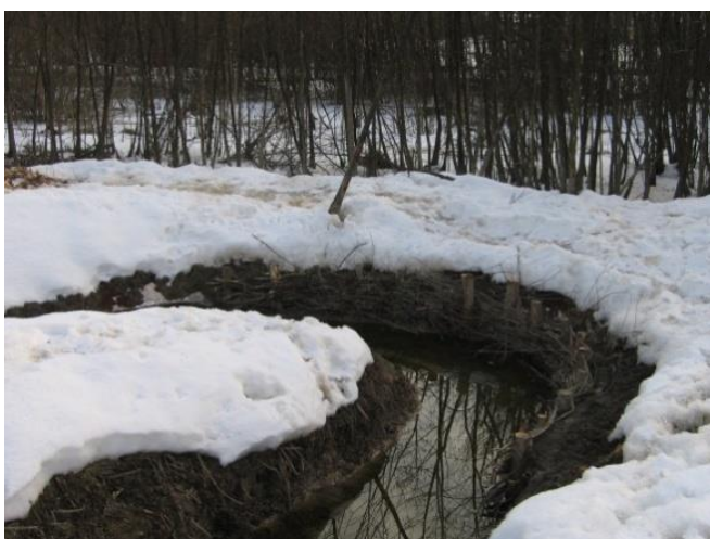
Slika 11: Detajl ekoremediacije. Oblikovanje meandra z vrbovimi popleti na poplavnem zadrževalniku v Podutiku.
