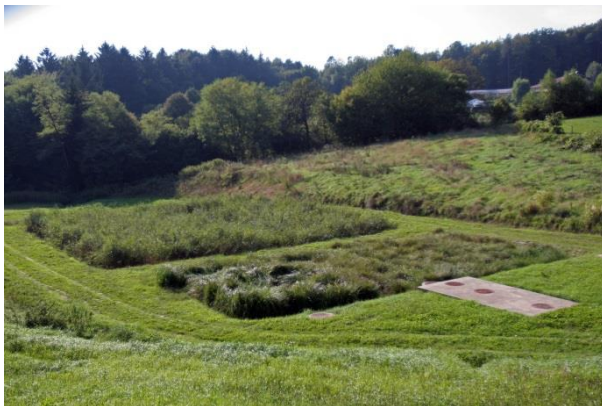
Slika 33: Hibridna rastlinska čistilna naprava za komunalno odpadno vodo v Svetem Tomažu.
