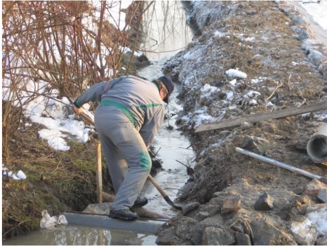
Slika 12: Detajl ekoremediacije. Gradnja pragov v vodotoku.
