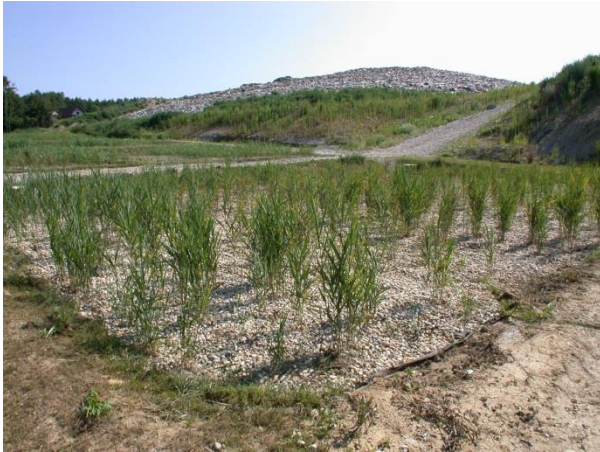
Slika 35: Hibridna rastlinska čistilna naprava za izcedne vode na odlagališču komunalnih odpadkov Ormož.
