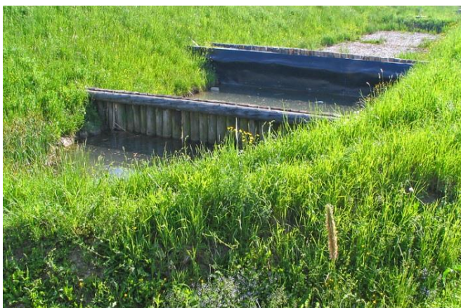
Slika 14: Ekoremediacija za čiščenje površinskega onesnaženja s kmetijskih zemljišč v melioracijskem jarku z iztokom v potok Lešnica v bližini Ormoža.
