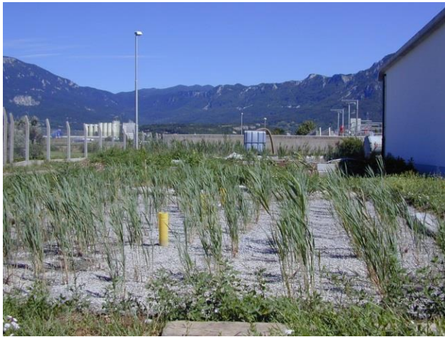
Slika 36: Hibridna rastlinska čistilna naprava za odpadne vode iz tekstilne industrije.
