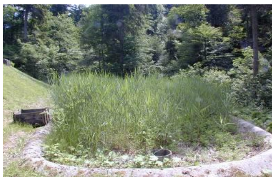
Slika 30: Delujoča rastlinska čistilna naprava z zrelem sestojem navadnega trsta.
