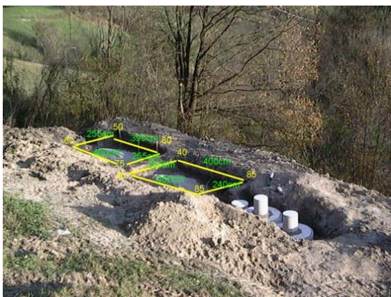
Slika 31: Primer izgradnje RČN za individualno hišo.
