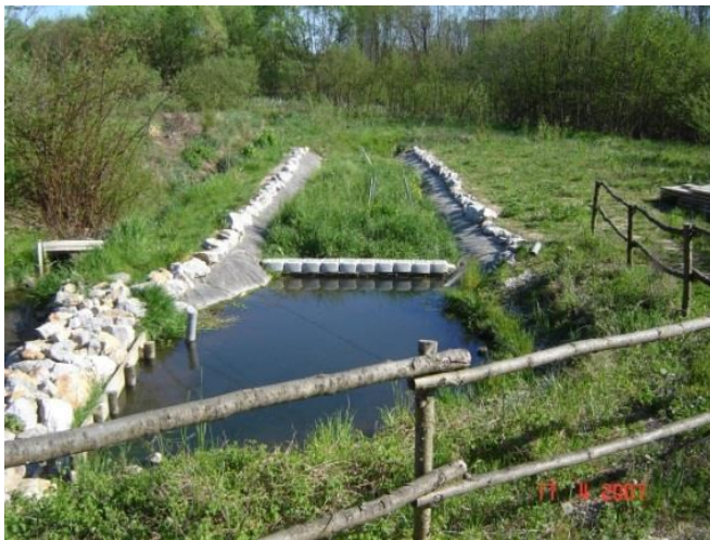
Slika 10: Ekoremediacijski jarek za čiščenje onesnaženega vodotoka.
