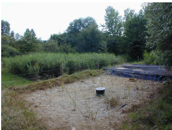
Slika 34: Hibridna rastlinska čistilna naprava za izcedne vode na odlagališču komunalnih odpadkov Barje, Ljubljana.
